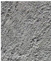
Ejemplo de preacabado rústico, aplanado o revoco: se requiere nivelar y quitar piedras sobresalientes para asegurar una superficie plana y rústica para la aplicación de la pasta.
